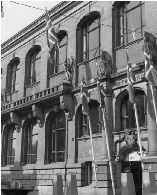
Turnhallen i St. Olavs gate var oppe i en svært alvorlig situasjon.
